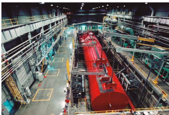
Prototipo del reactor S5G ( Submarine, 5th Generation core, General Electric ). Instalado bajo tierra, funcionó entre 1965 y 1995 para entrenamiento de casi 12.000 oficiales y personal que operaron la flota nuclear. La plataforma, sumergida en una pileta con agua, podía simular ruidos sostenidos para testear la circulación natural en el reactor. Este tipo de reactor fue instalado únicamente en el submarino Narwhal (SSN 671). Nótese la longitud de la estructura: no solamente se instaló el reactor, sino también el resto de la planta propulsora.
