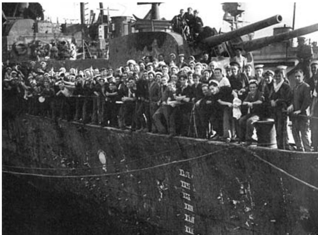
El *Penélope* (HSM *Peleponon*) a su arribo a Gibraltar. Innumerables taponos de madera obturan orificios en su casco.
